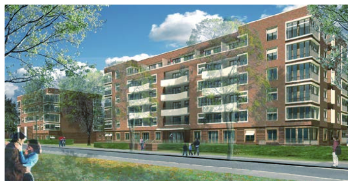
Aktuelles Bauprojekt: Bethanien-Höfe Eppendorf in Hamburg
