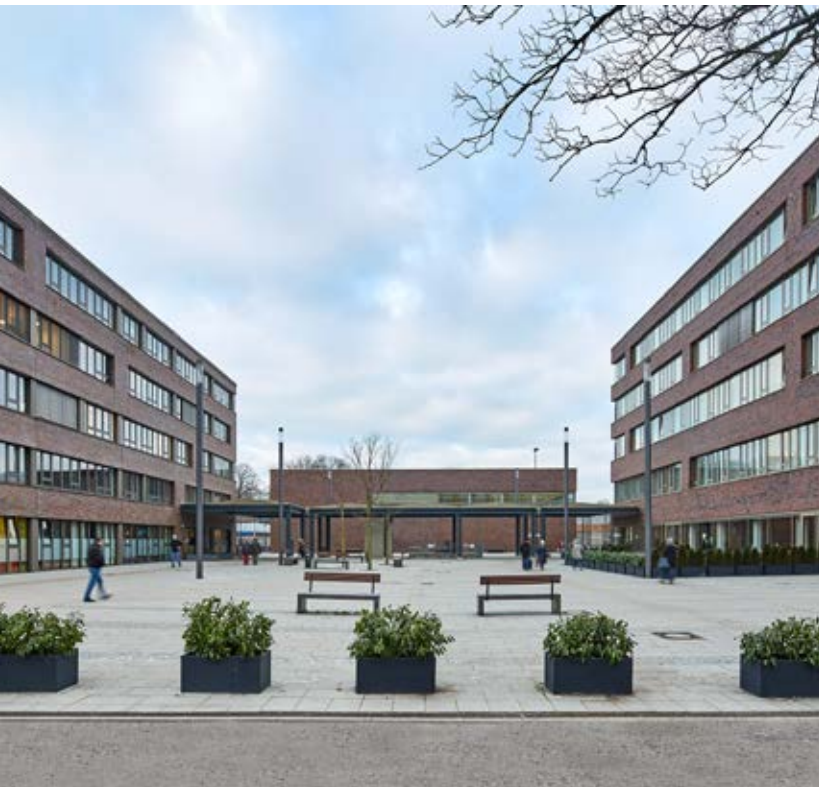
In direkter Nachbarschaft: Der Bau des KAIFU-Ärztelhauses (links) neben dem AGAPLESION DIAKONIEKLINIKUM HAMBURG (rechts) wurde Ende 2016 abgeschlossen
