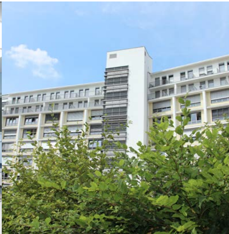
Seit dem 1. Januar 2016 stehen im AGAPLESION MARKUS KRANKENHAUS im Hauptbettenhaus neue, attraktive Patientenzimmer zur Verfügung
