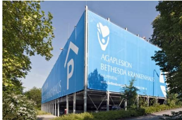
Das Parkhaus bietet 160 Parkplätze für Mitarbeitende und Besucher
