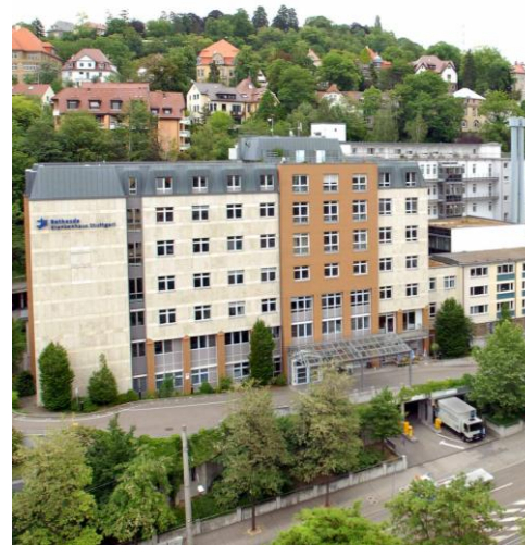
Das Foto zeigt einen Blick auf das AGAPLESION BETHESDA KRANKENHAUS STUTTART in der Hohenheimer Straße – eine Klinik der Allgemeinversorgung mit diakonischem Profil seit über 100 Jahren am selben Standort im Herzen von Stuttgart.
