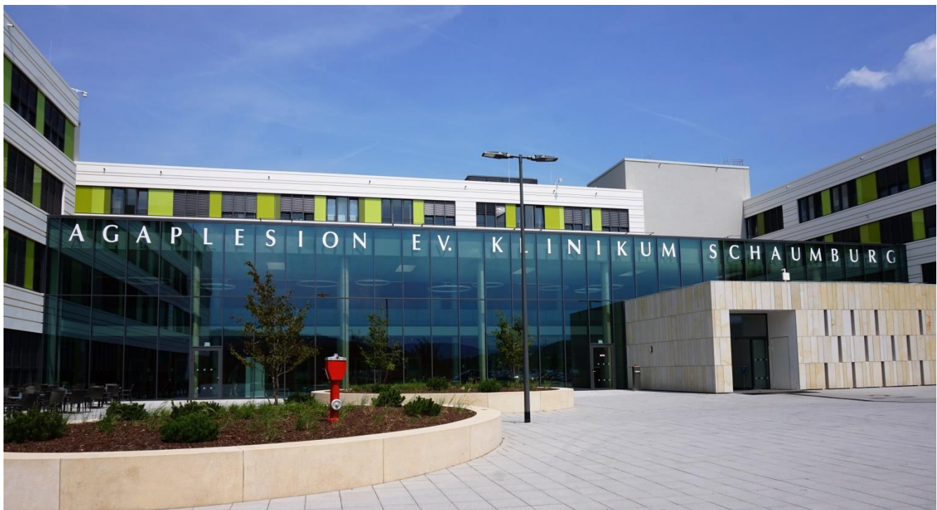
Frontansicht AGAPLESION EV. KLINIKUM SCHAUMBURG gGmbH
