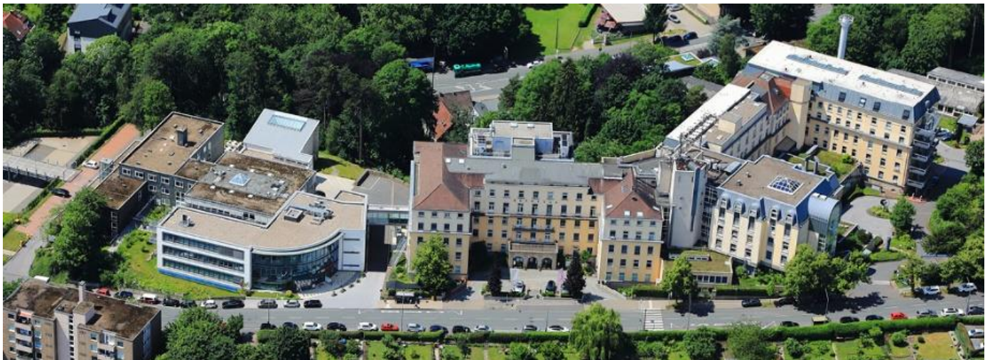
Luftaufnahme des AGAPLESION BETHESDA KRANKENHAUSES mit Facharztzentrum und Parkhaus
